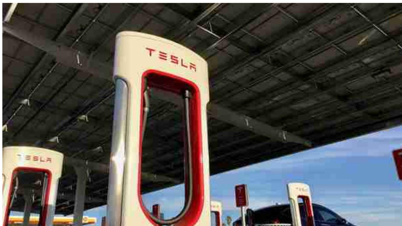
在超充路径上，小鹏与特斯拉代表了两种不同的方向。作为较早在超充上发力的车企，特斯拉采用的是高电流方案，即提升电流实现更高的充电功率。其V3超级充电桩的峰值电流就已经能够达到600A以上，这已经与当下普遍正在开发或已经发布的800V电压平台超充的峰值电流在一个水平上。而接下来即将发布的特斯拉V4充电桩，预计其电流恐怕还要更高。
